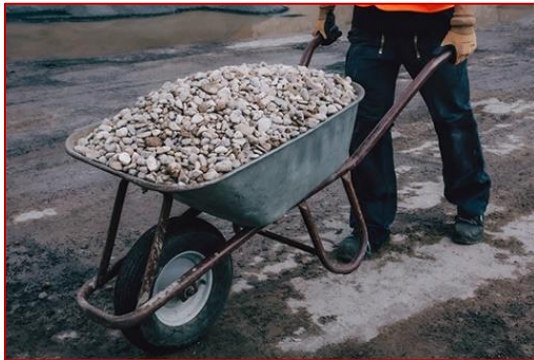
Foto: IG BAU | William Diller
