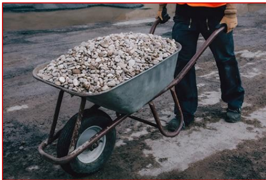
Foto: IG BAU | William Diller
